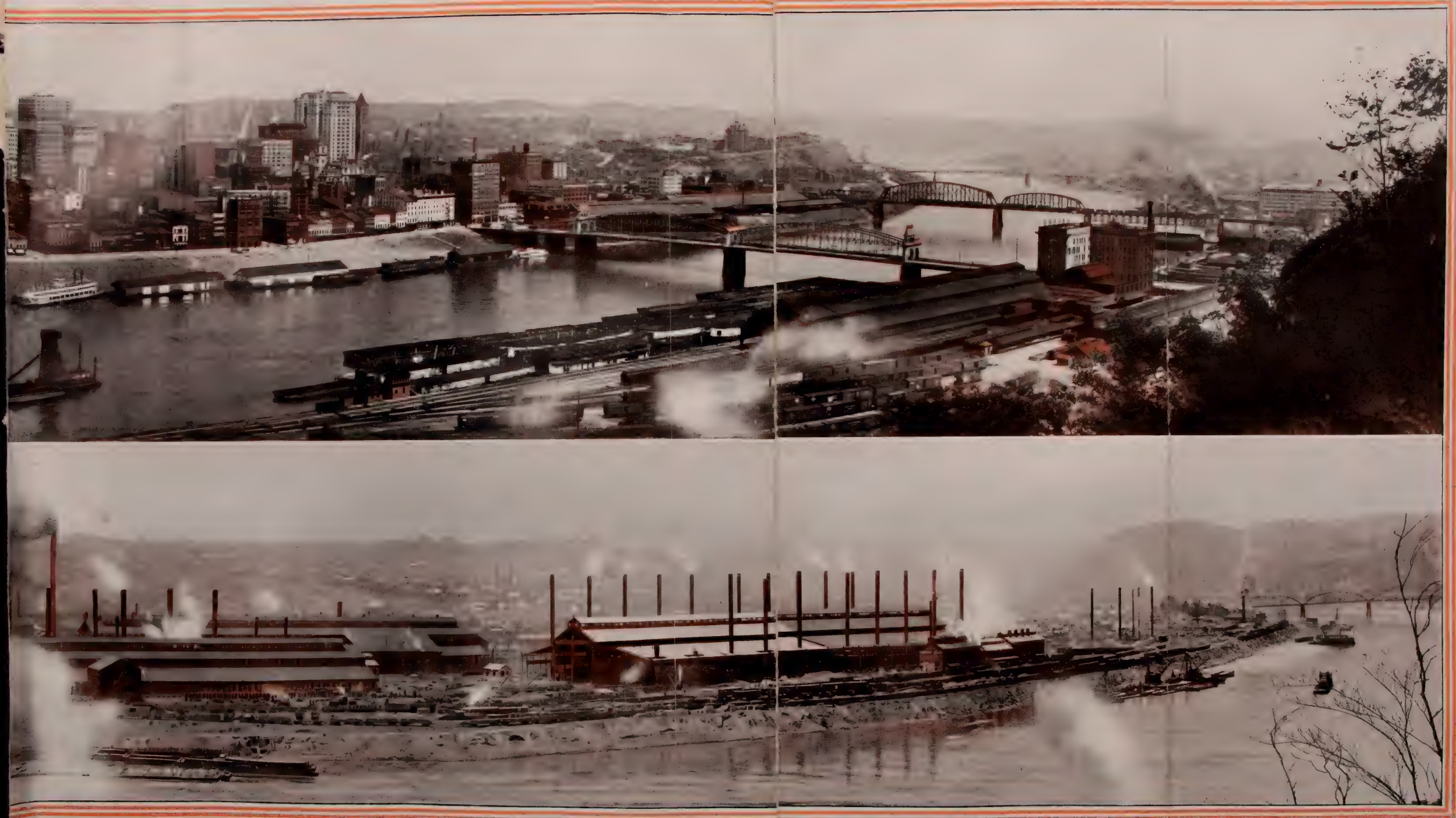
Monongahela; la photographie du haut montre la partie de la ville construite sur la presqu'île formée par ces deux rivières. En bas, par-delà l'Allegheny, s'aperçoit la ville proprement dite, étagée sur les collines avoisinantes. Les hauts fourneaux qui appartiennent au trust Carnegie de l'acier. Malgré leur importance, ils ne constituent qu'un coin infime de cette forge dont le produit est la ville de Pittsburg.
